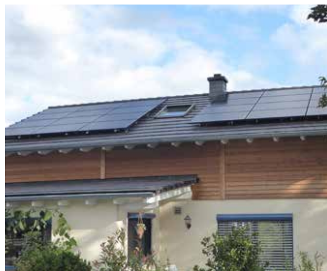
PVT-Dach / Photovoltaik-Thermie: Solarzellen mit integrierten Wärmetauschern / Foto © 2Power
