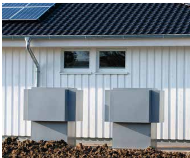
Große Wärmetauscher für Luft-Wasser-Wärmepumpen / Foto © Viessmann
